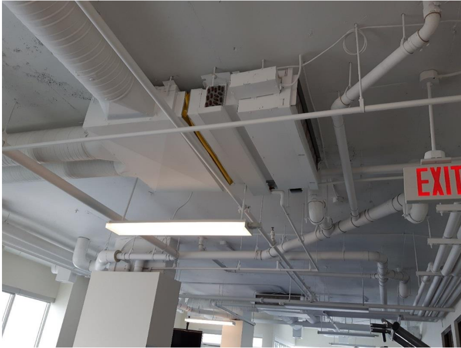
Photo 24 Fan coils
